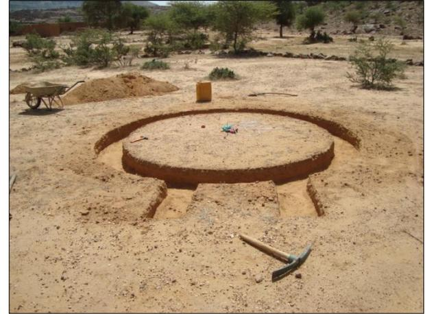
Proceso de marcado y excavación de la cimentación (25cm)
