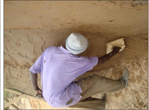
Preparación de la mezcla y ejecución de la capa de acabado
