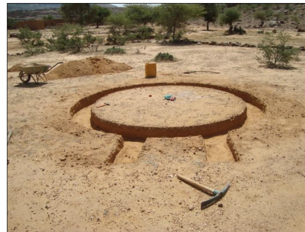
Procés de marcat i excavació de la fonamentació (25cm)
