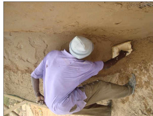
Preparació de la mescla i execució de la capa d'acabat
