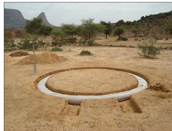
Ompliment de les files de la fonamentació
