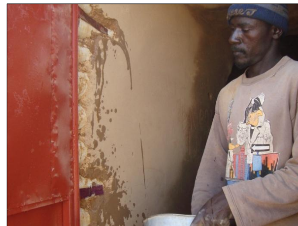
Construcció del rebedor / Col·locació de la porta
