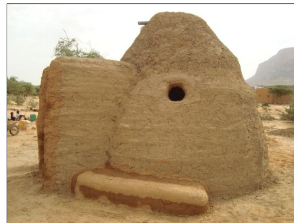
Procés constructiu i acabat final
