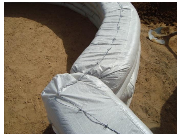
Primeres 10 – 12 filades / Filferro d'espines
