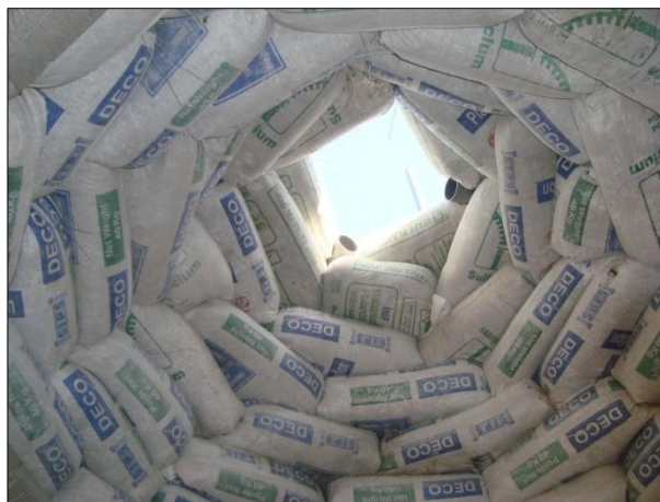
Formació de les ventilacions superiors en les darreres files / Vista interior / Aspecte final
