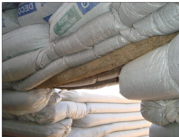
Trava de les files en l'entrega amb la porta / Formació del dintell pel pas de porta
